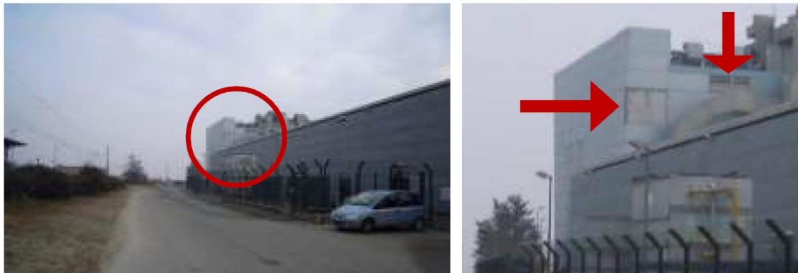
Figura 31. Pannelli Alucobond da ripristinare.
